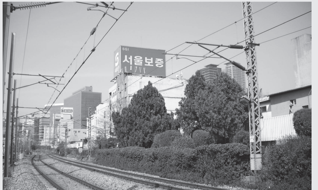
▲서울지하철 1호선 서울역과 남영역 사이에 위치한 절연구간. 이 구간에서는 전동차 전원이 차단되므로 객실 내 전등과 뱅·난방 장치가 꺼진다. 이때 전동차는 관성을 이용해 나아간다.
